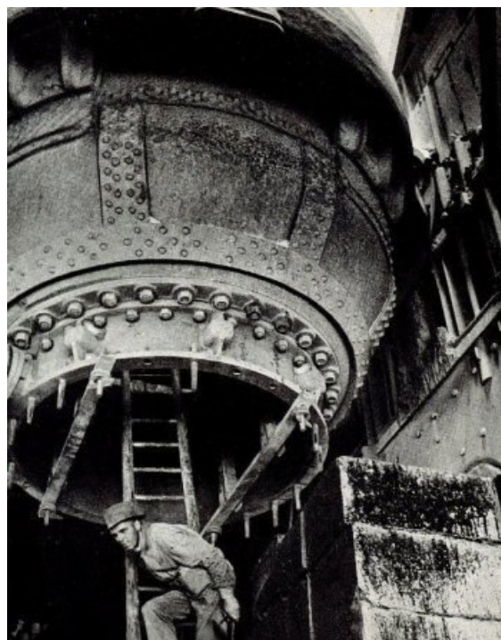
Werken in de staalfabriek van Watenstedt
